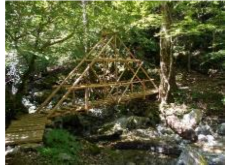
三角形の木の橋。
