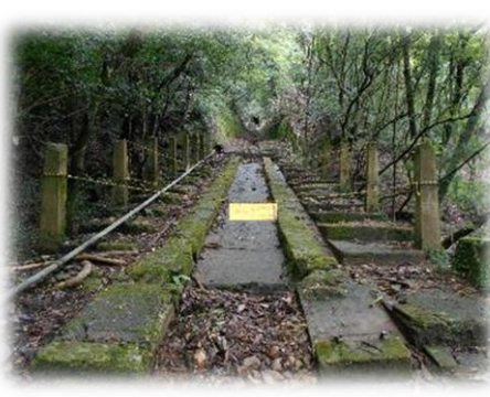
ケーブル廃線跡
